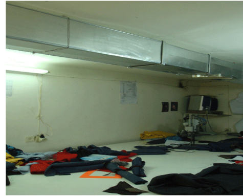
Der gleiche Tisch mit Lüftungsschacht oben drauf
