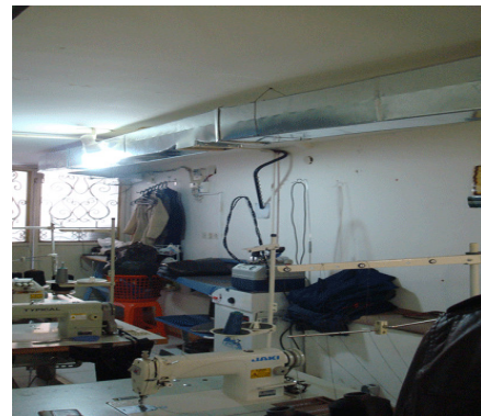
Der gleiche Raum mit Lüftungsschacht unter der Decke
